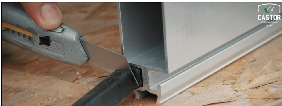
6. Mettre en place le joint bas dans son logement, Le couper au cutter. Ne pas hésiter également, à laisser une sur longueur de 5mm de part et d'autre.
