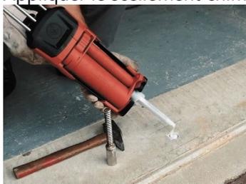
10. Mettre la douille avec son bouchon à l'aide d'un marteau, vérifier que le bouchon de propreté obturant la douille soit au même niveau que le sol fini.
